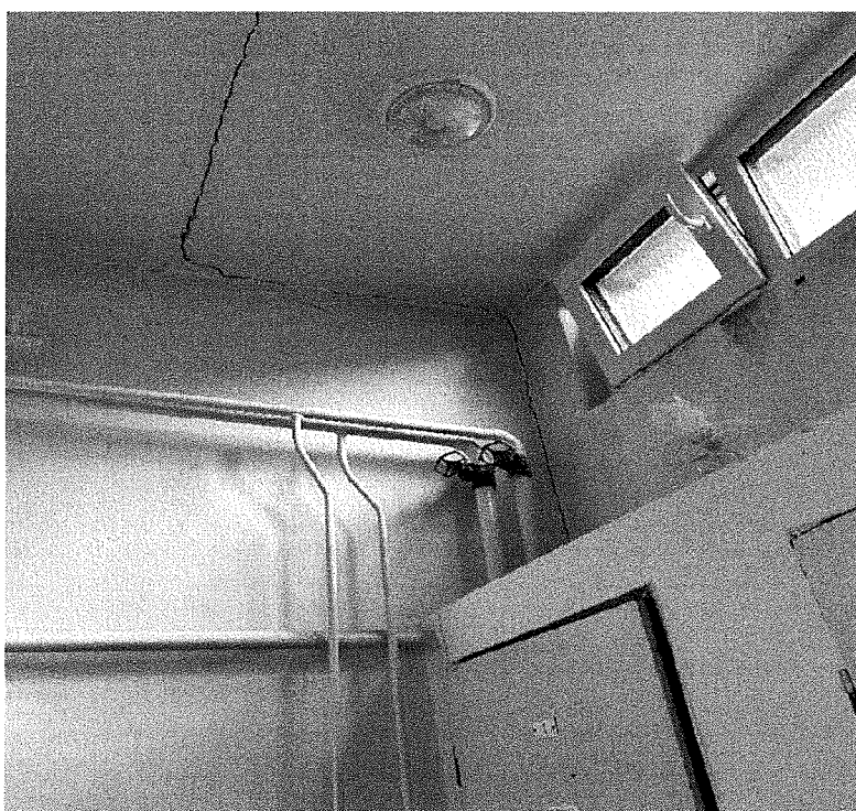
Obr. č.1: Výrazná trhlina v jihovýchodním rohu objektu ve spáře mezi podélnou a příčnou stěnou a ve spáře mezi stropními panely. Výrazná trhlina je po celé délce spáry mezi stropními panely.
